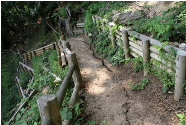
8/10 歩道ひび割れ(中禅寺湖北岸・千手付近)
